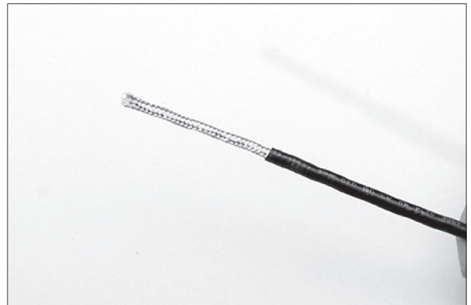
Figura 3.7: Retiro de la cubierta plástica externa
