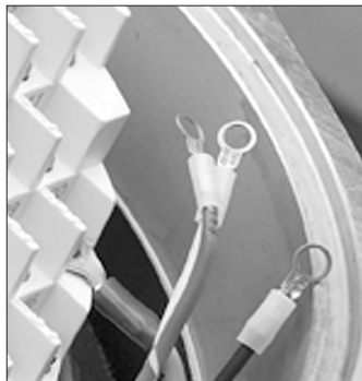
Figura 3.10: Terminais de compressão
